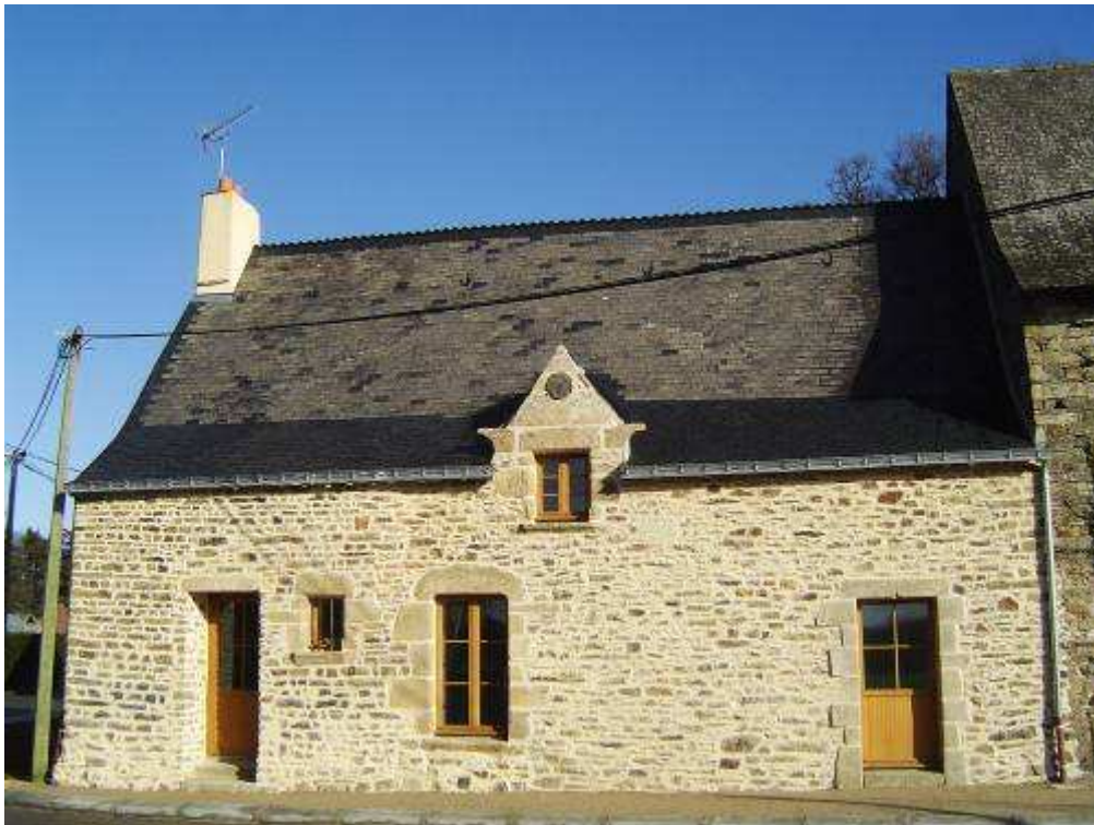
Secteur Ouest - Façade sud
