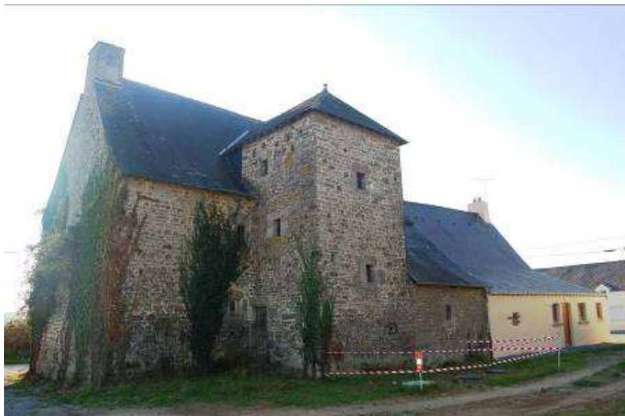
Secteur Est – Façade nord
